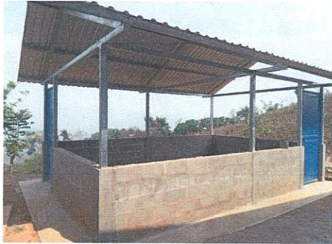
Foto1: mejoramiento para terminación de construcción de modulo.
