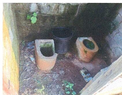
Foto 4: Mejoramiento para colocación de tazas sanitarias.
