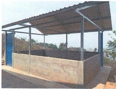
Foto 3: Mejoramiento de terminación de columnas de modulo.
