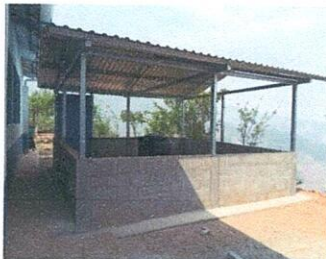
Foto 5: Mejoramiento para terminacion de valcones.
