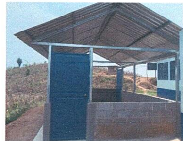
Foto 6: Mejoramiento de terminacion de paredes de modulo.
