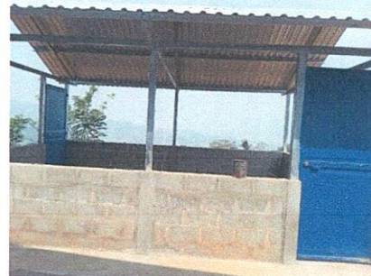
Foto 2: Mejoramiento para terminación de paredes de modulo.
