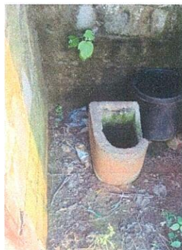
Foto1: Mejoramiento para colocación de taza sanitaria.
