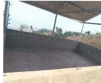
Foto 2: Mejoramiento para terminación de piso ceramico.
