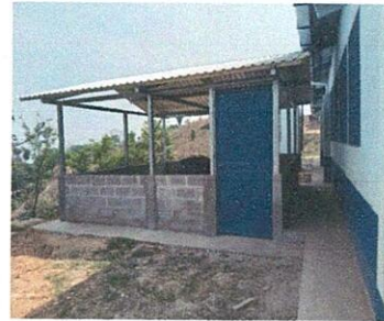
Foto 4: Mejoramiento para terminacion de ventanas.
