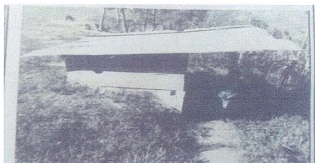
Foto 3: Mejoramiento para colocación de techo sanitario.
