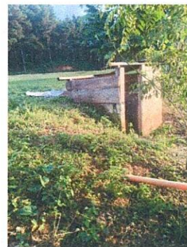
Foto 2: Mejoramiento para realización de paredes sanitarias.
