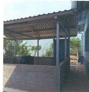
Foto 6: Mejoramiento para terminación de techo.
