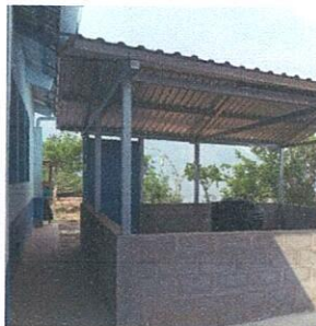
Foto 5: Mjoramiento de terminación de techo de modulo.
