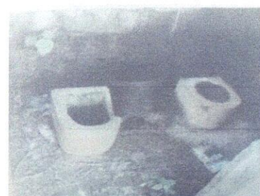
Foto 6: Mejoramiento para piso de sanitarios.
