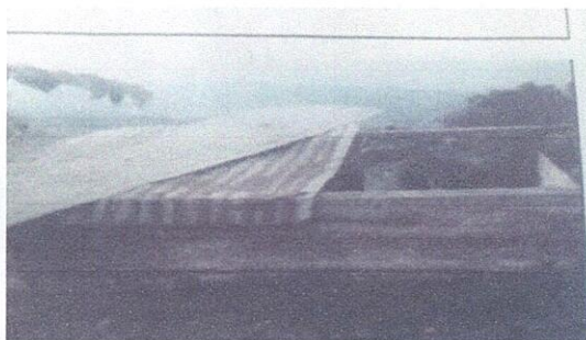
Foto 5: Mejoramiento para colocación de costaneras sanitarios.
